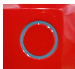
传感器安装时请确保密封胶圈安装到位
